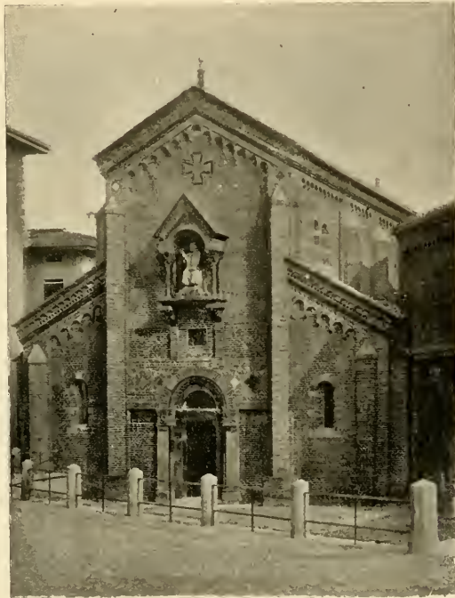
Fig. 322 — Facciata della chiesa dei Santi Pietro e Paolo presso Santo Stefano a Bologna (sec. xii)
